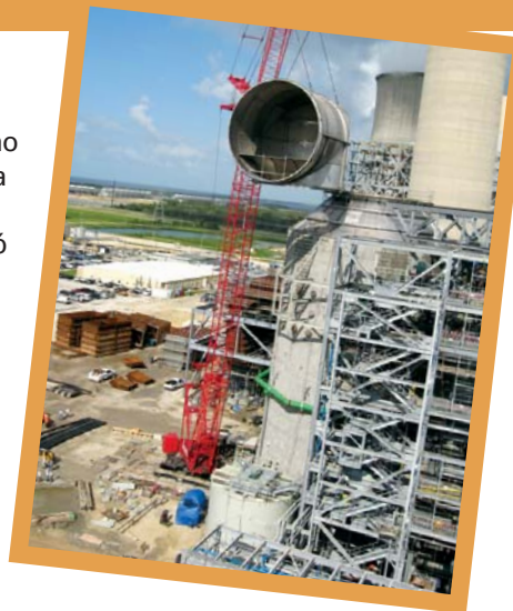
Zachry instala un codo de transición en la chimenea para el sistema de control de calidad de aire en Crystal River, Fla. Fotografía / Cortesía de Thomas Augustine
