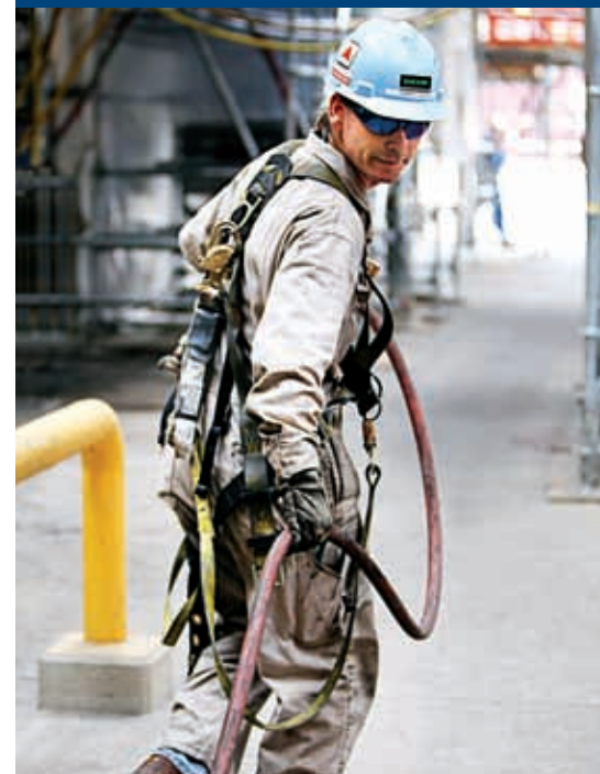
El Calderero, Dammon Marion, jala una manguera a su área de trabajo, conforme Zachry prepara la instalación de la batería de límite para la unidad UNIBON. Fotografía / Alissa Hollimon
